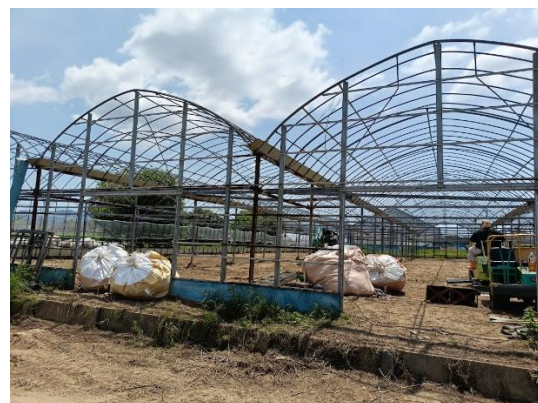
図②：リノベーション途中のハウス
