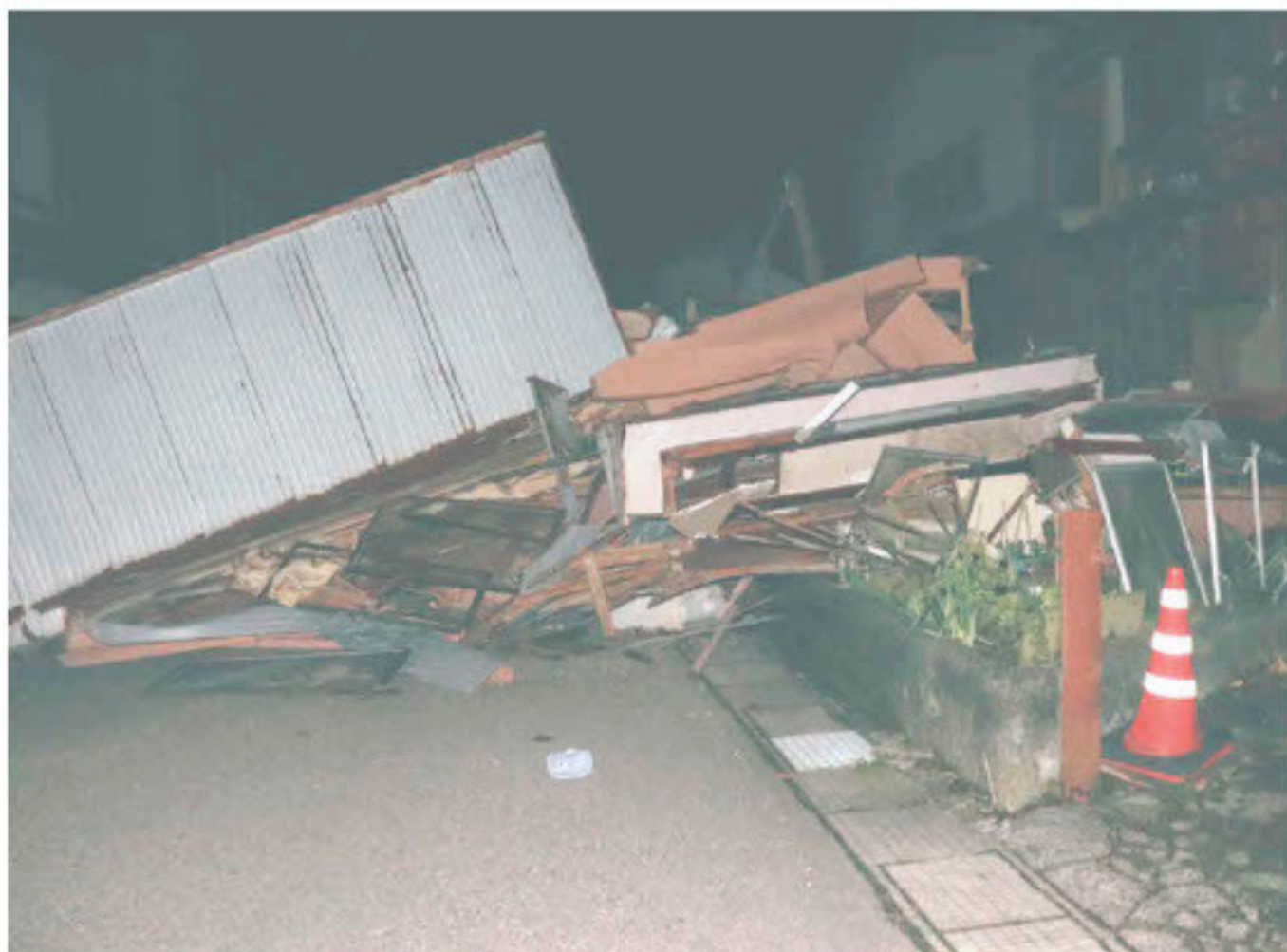
倒壊し原形をとどめない家屋=1日午後、石川県能登町で
