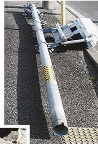
① 腐食して倒れた信号機 ② 信号機の根元部分=いずれも三重県鈴鹿市で(同県警提供)
